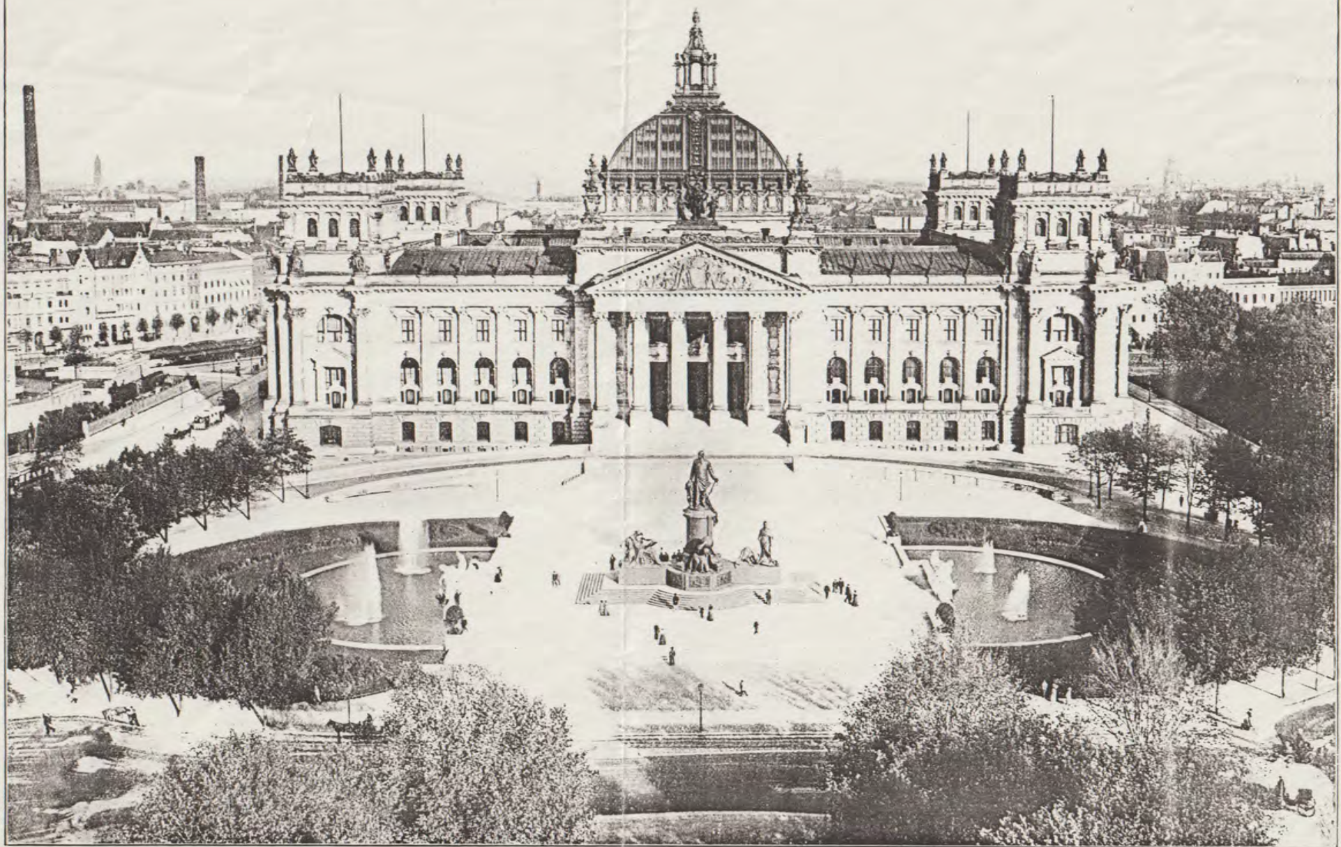
REICHSTAGSGEBÄUDE UND BISMARCK-DENKMAL.
